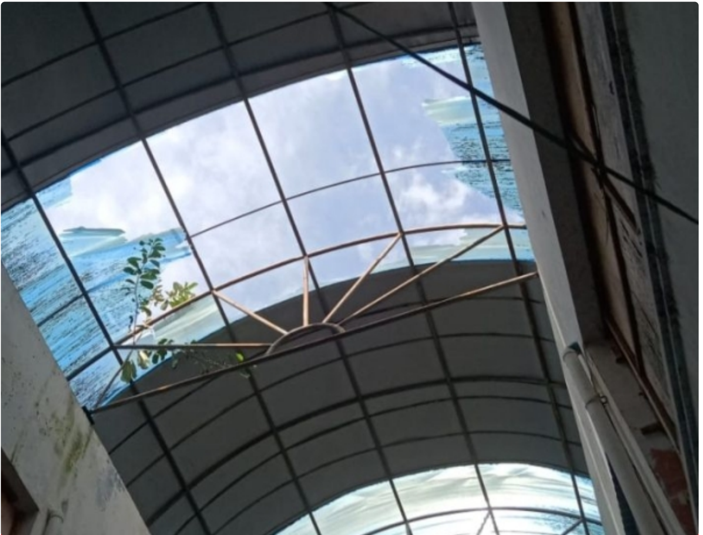
Nampak atap pasar Pekkae yang rusak mengakibatkan air hujan masuk ditengah pasar
