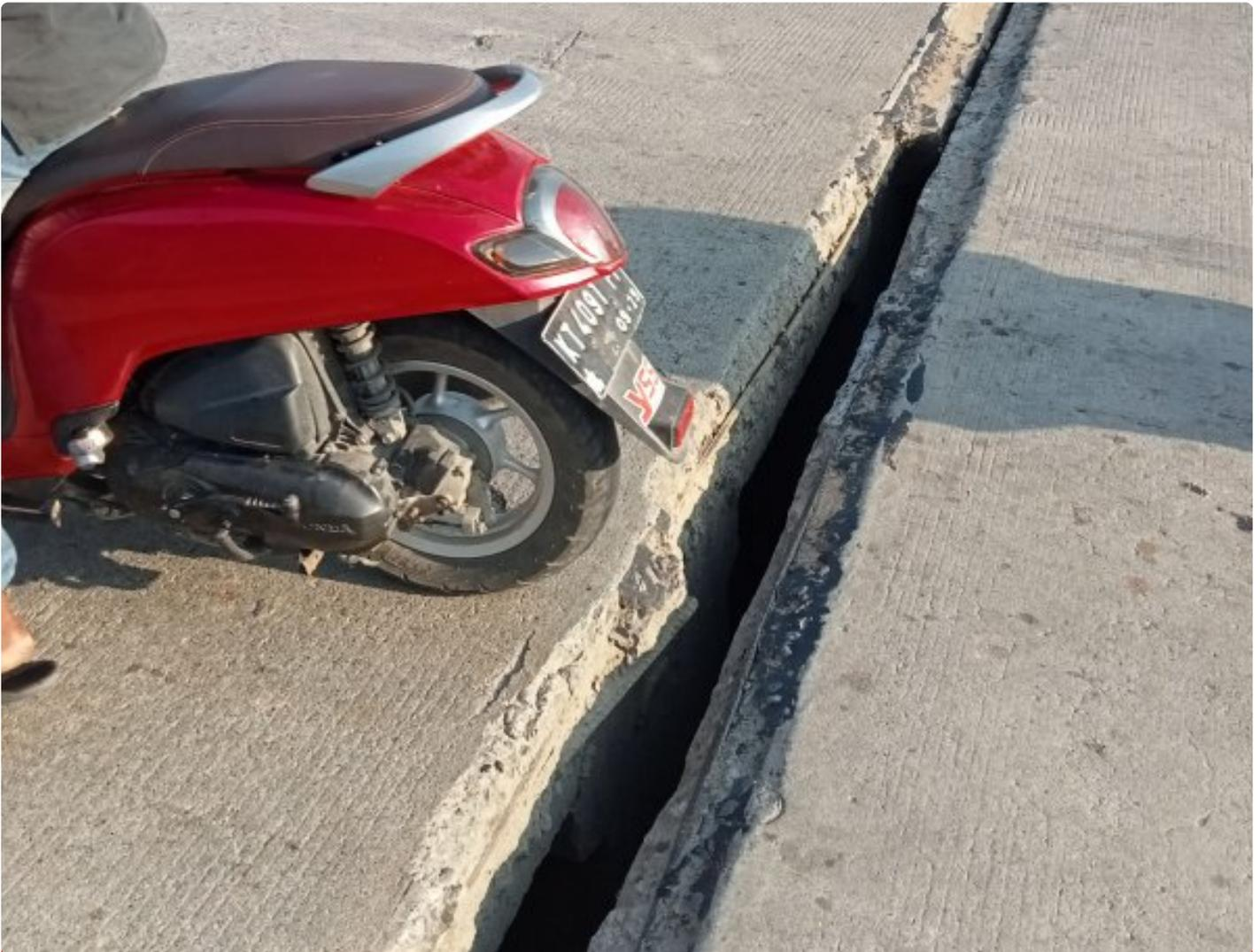
*Nampak lubang selebar 20 cm di sambungan jalan fly over Pekkae*
